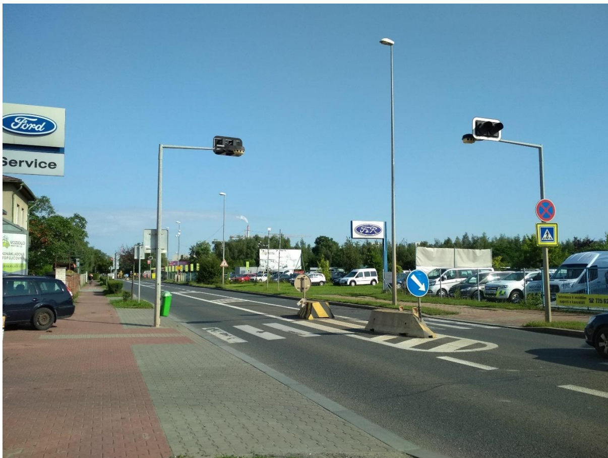
Obrázek: Jeden z problematických přechodů (mezi ul. Na Slavíkově a ul. Parková) ve stávající podobě.
