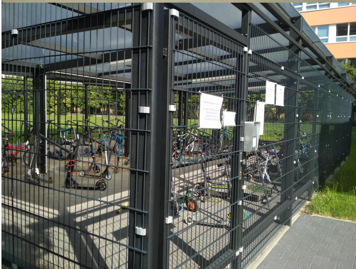
Obrázky: Stav přístřešku před ZŠ Burešova – přístřešek s vyšší kapacitou než celkovou kapacitou uvažovanou pro ZŠ Kutnohorská. U dveří viditelný systém čtečky čipů. Přímý dohled zajištěn z okna vrátnice a záznam kamerou.
